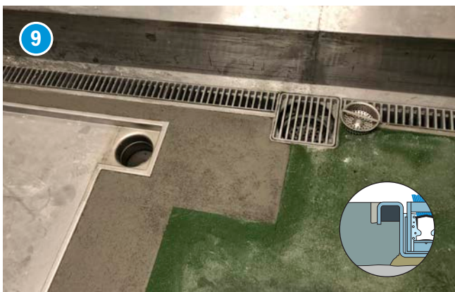
9 Grubenrand um die VA Wanne ausgießen und sauber anpassen. Fill in the edges of the pit and make sure the material is connecting the stainless steel trays. Vul de randen van de put en zorg ervoor dat het materiaal de RVS trays verbindt. Ajustez proprement l'endroit entre le sol et le bac.
